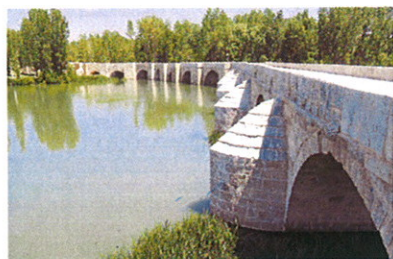
Puente restaurado de Torquemada, a inaugurar próximamente.
