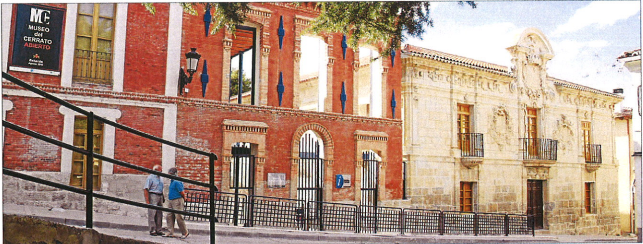
Fachada principal del Museo del Cerrato Castellano (MC) de Baltanás.
