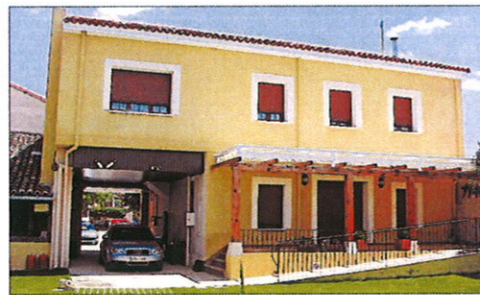
Fachada interior de la Casa Rural El Portal de Cerrato.
