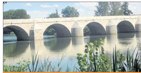
Puente de Torquemada sobre el Pisuerga.
